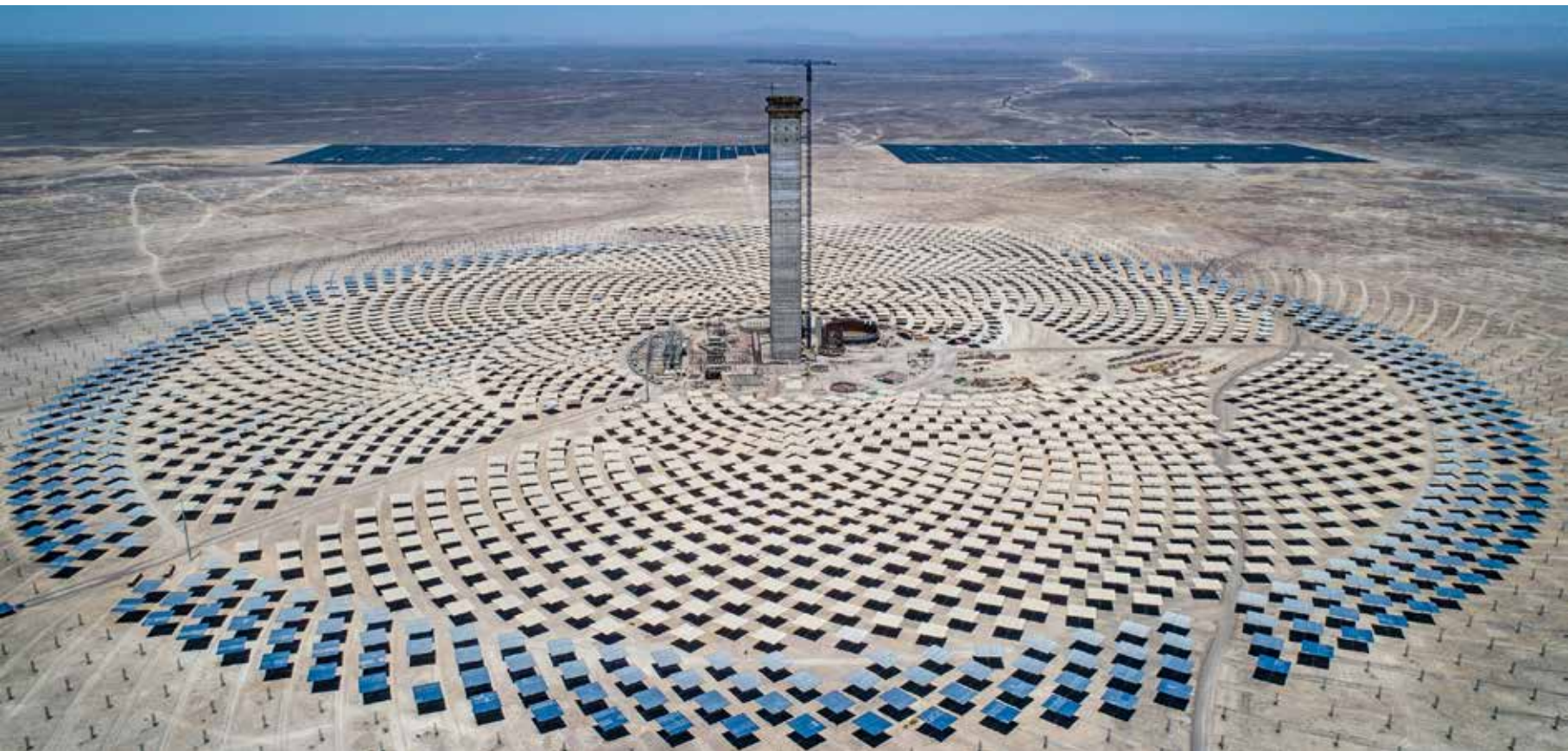
Imagen aérea de la 1ª Planta de Concentración Solar de Chile, Cerro Dominador, Región de Antofagasta.
